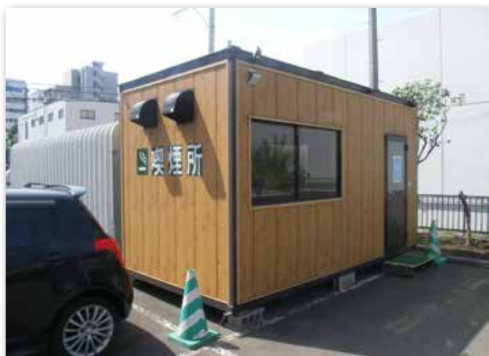
本社敷地内に設置した喫煙室
