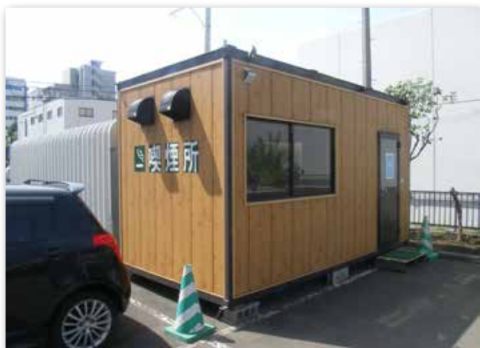
本社敷地内に設置した喫煙室
